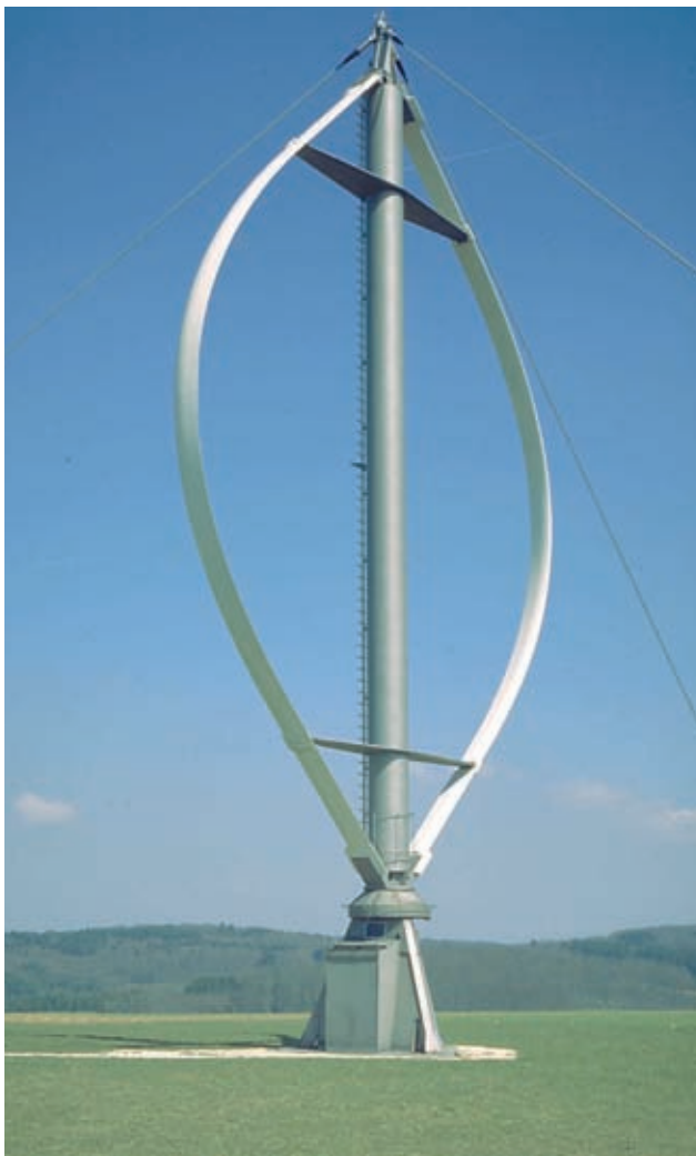
Figura 1.9 - Aerogenerador tipo Darrieus
