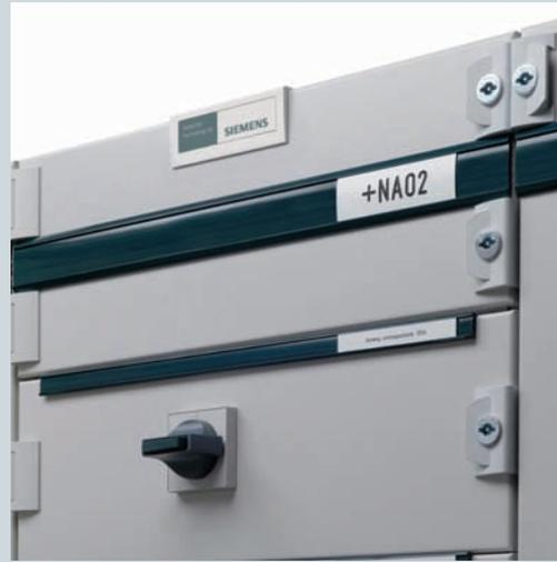
Sistema de identificación estandarizado de las columnas y de los compartimentos
