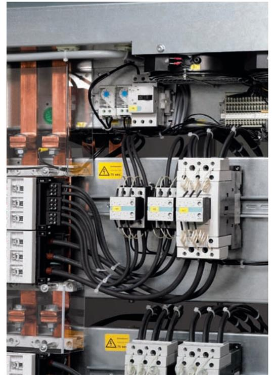
Los módulos de capacitor pueden usarse con o sin filtro.
