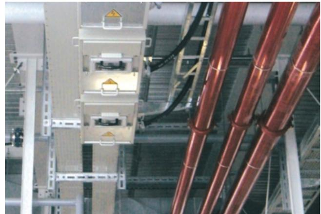
Carga de incendio baja en la canalización eléctrica prefabricada
