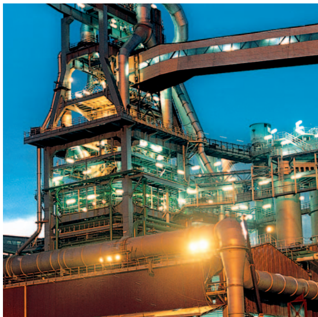
Aplicación industrial: Refinería
