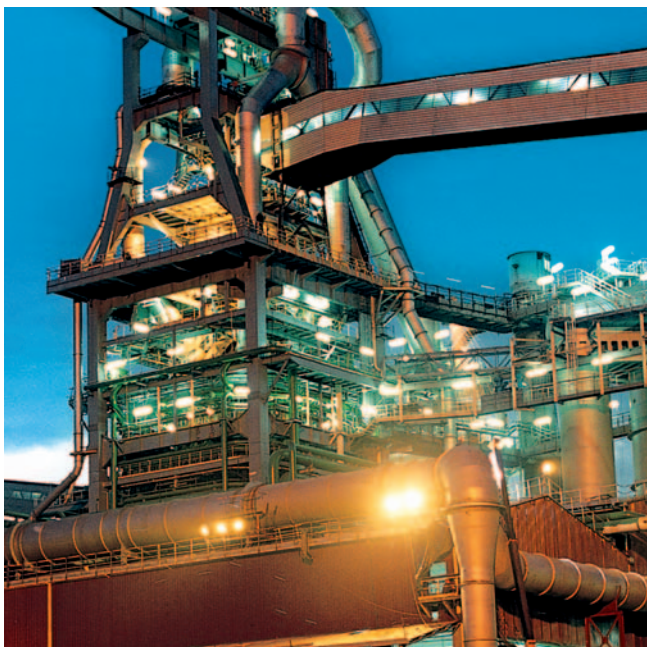
Aplicación industrial: Refinería
