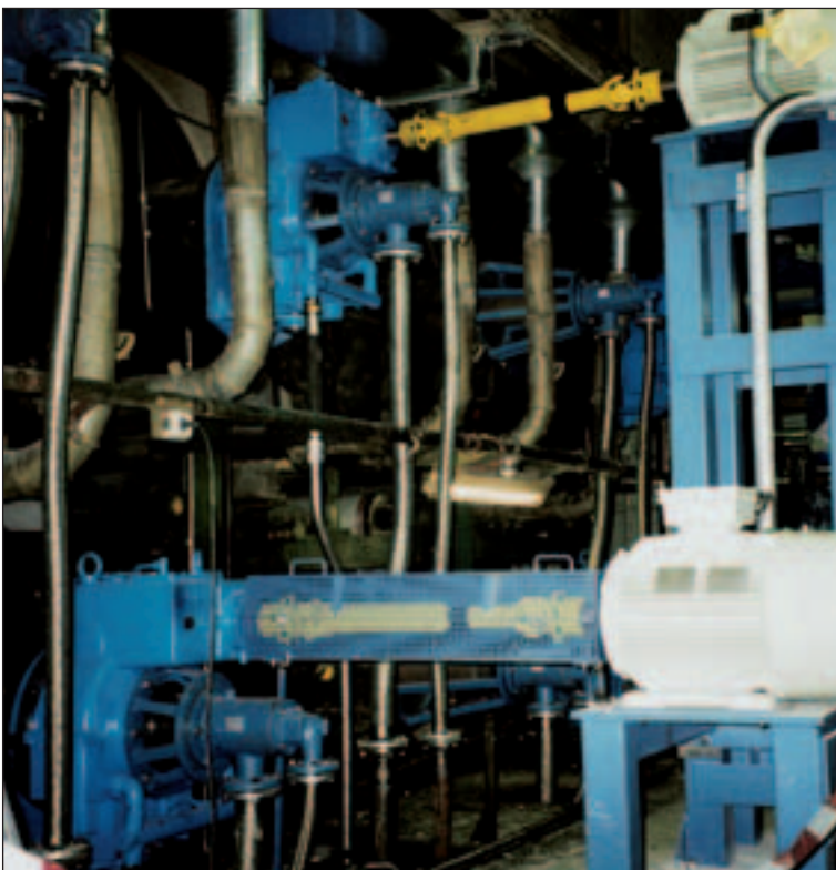
Trockenzylinderantrieb mit FLENDER-Stirnrad-Aufsteckgetriebe der Bauart SHZP 300 Drying cylinder drive with shaft-mounted FLENDER helical gear units of type SHZP 300 Entraînement du cylindre sécheur avec réducteur cylindrique à arbre creux du type SHZP 300
