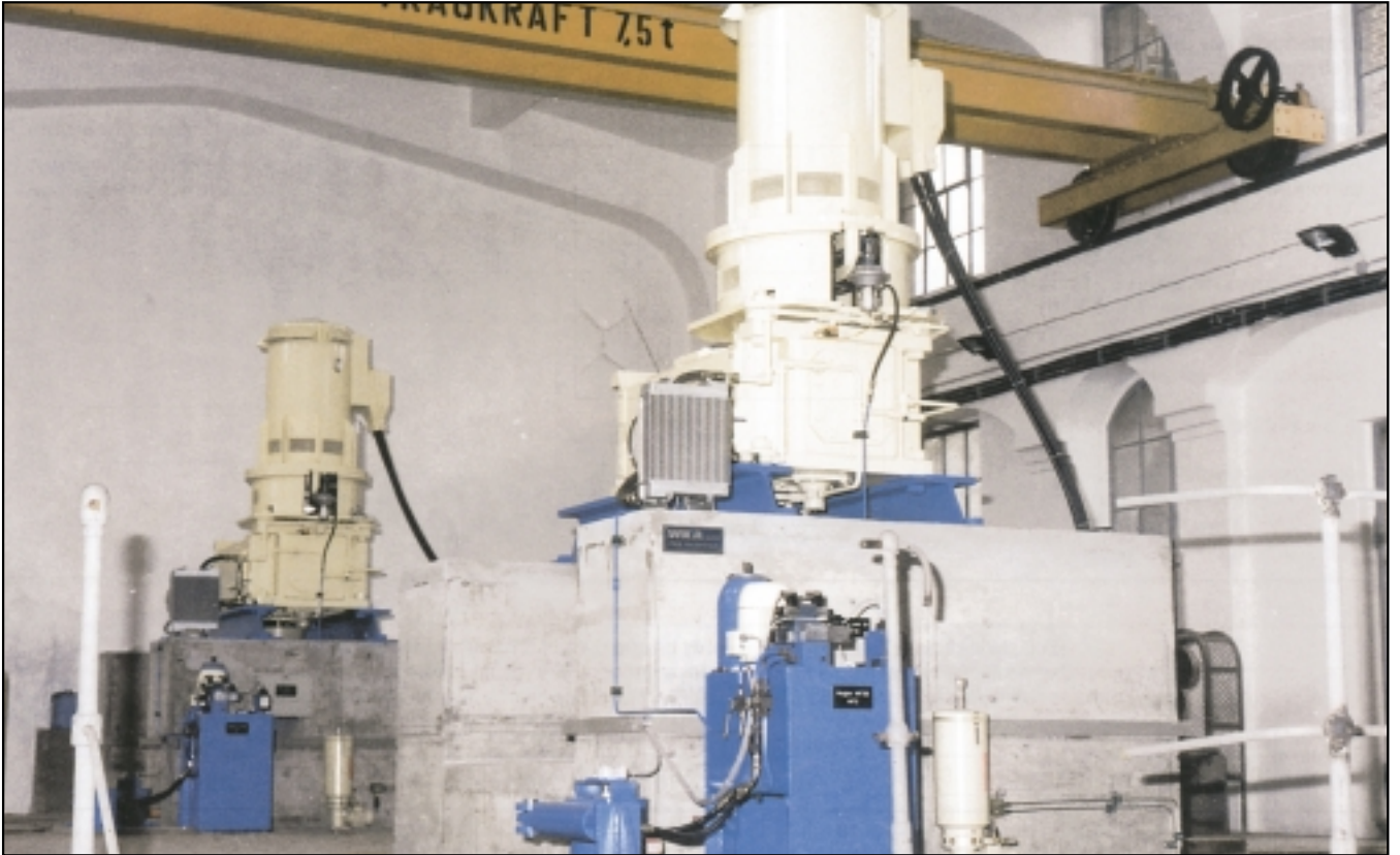
Antriebstechnik von FLENDER bestehend aus Generator, Kupplung, Bremse, Stirnradgetriebe und Luft/Ölkühler in einer Wasserkraftanlage Power transmission equipment by FLENDER consisting of generator, coupling, brake, helical gear unit, and air/oil cooler in a hydroelectric plant Entraînement FLENDER d'une centrale hydroélectrique comprenant: générateur, accouplement, frein, réducteur à engrenages cylindriques et refroidisseur huile/air
