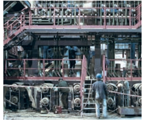
An eye for detail: Siemens VAI specialists on site
